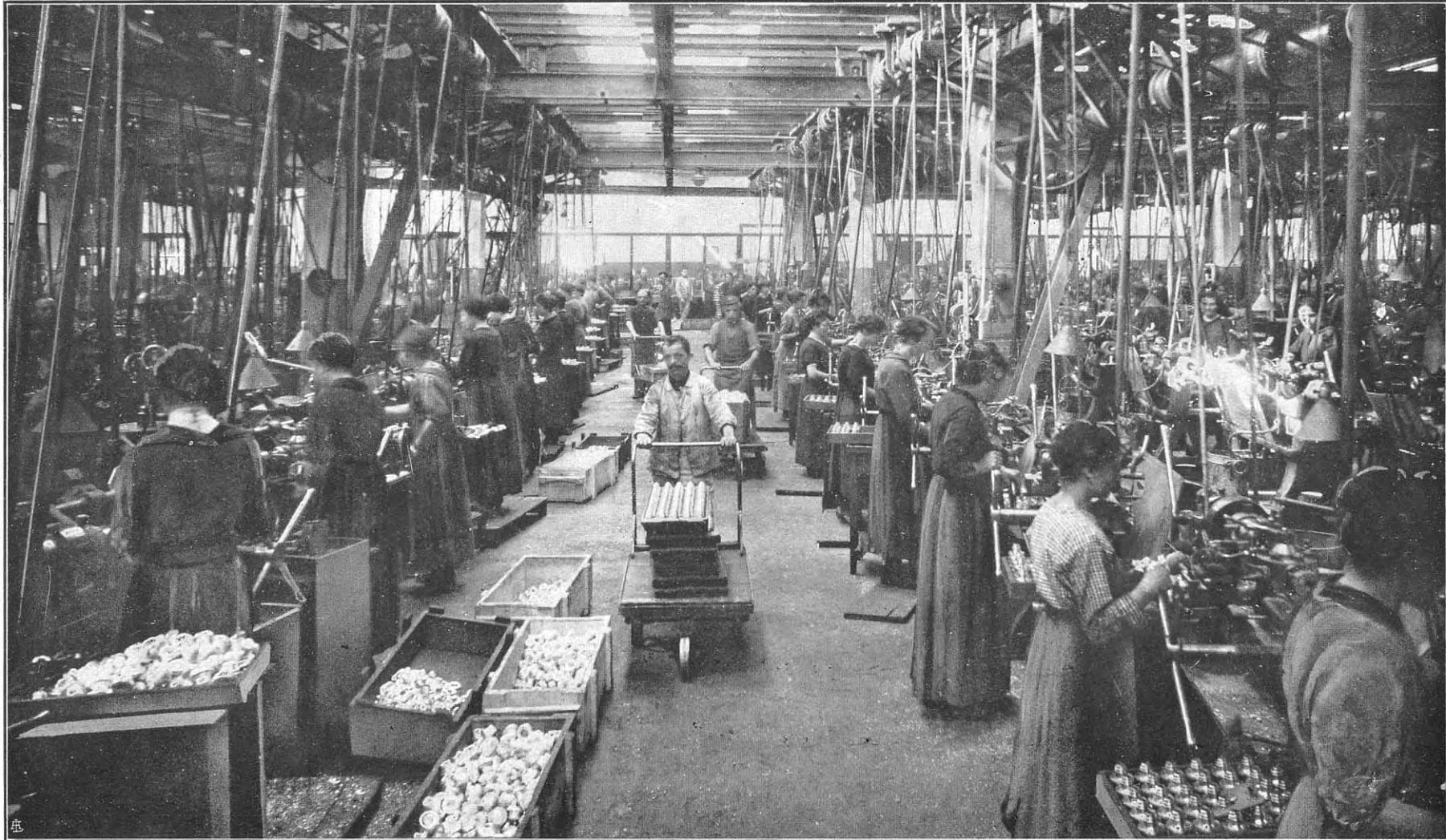
Reparto torneria a revolver per la lavorazione dei corpi, anelli e coperchietti delle Spolette.
